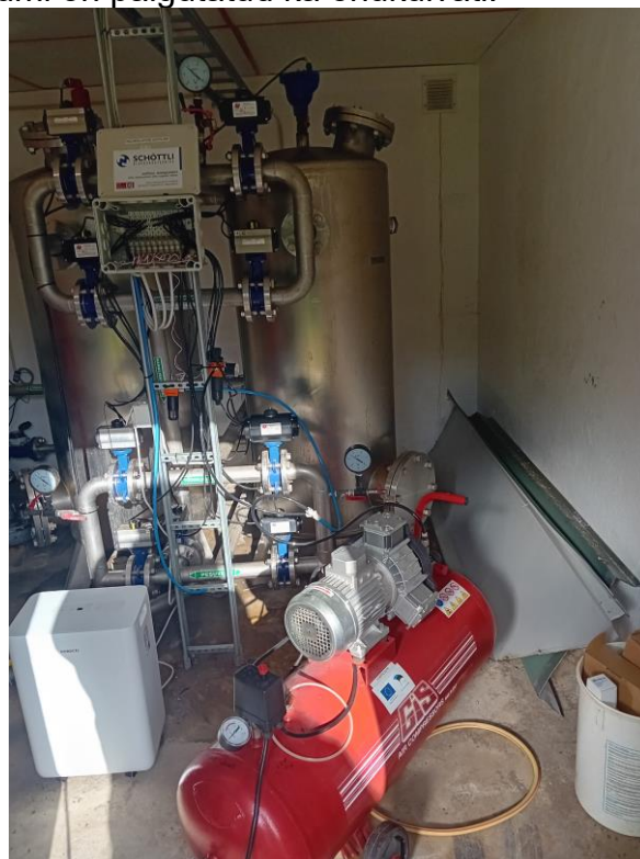
Foto 5-6 Raasiku Tehase pumpla välisilme ja sisevaade (paarisfilter)
