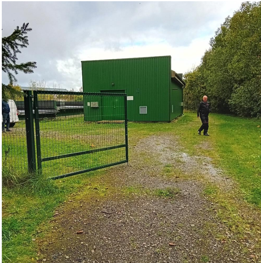
Foto 5-1 Aruküla pumpa nr 3 välisilme
