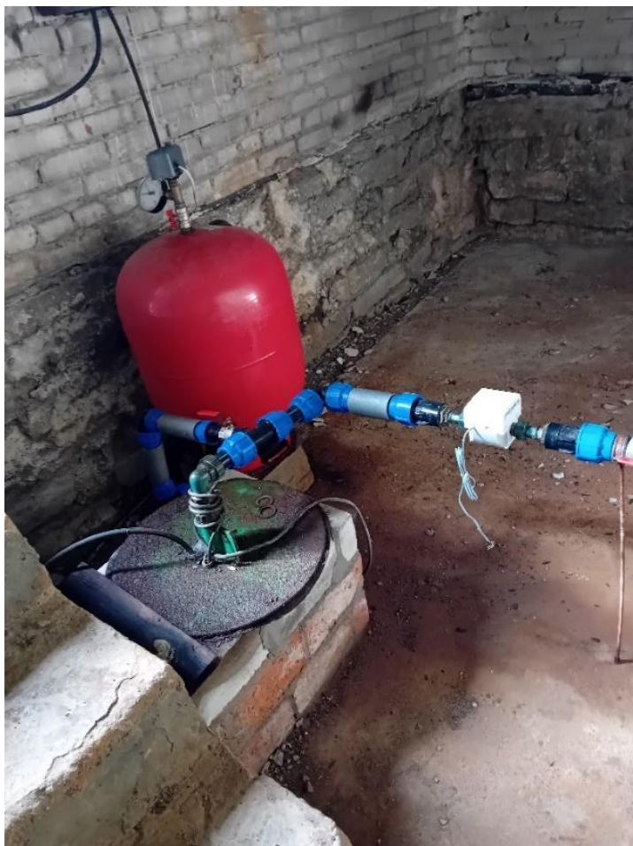
Foto 5-10 Perila küla puurkaevpumpla sisevaade
