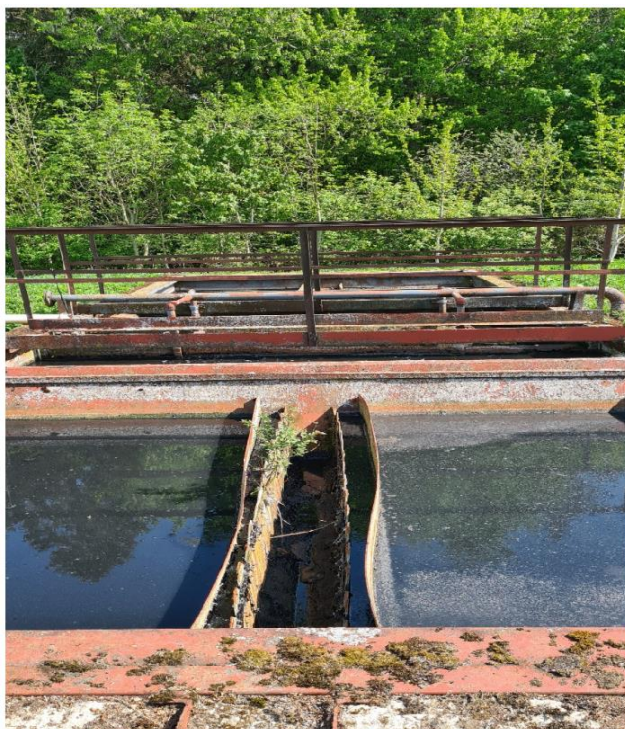
Foto 6-7 Peningi amortiseerunud reoveepuhasti BIO-50
