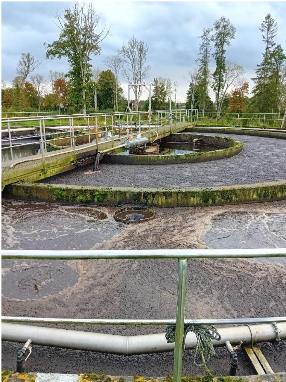
Foto 6-2 Aruküla reoveepuhasti (esiplaanil aerotank, järgneb denitrifikatsioonimahuti ja keskel järelsetiti)
