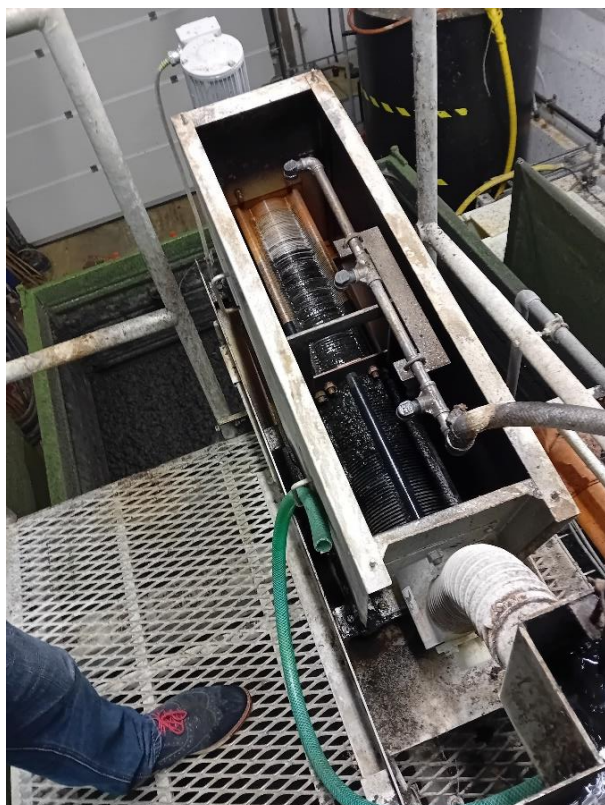
Foto 6-3 Võre-liivapüünis ja alumisel fotol liiga väikese toodanguga mudapress
